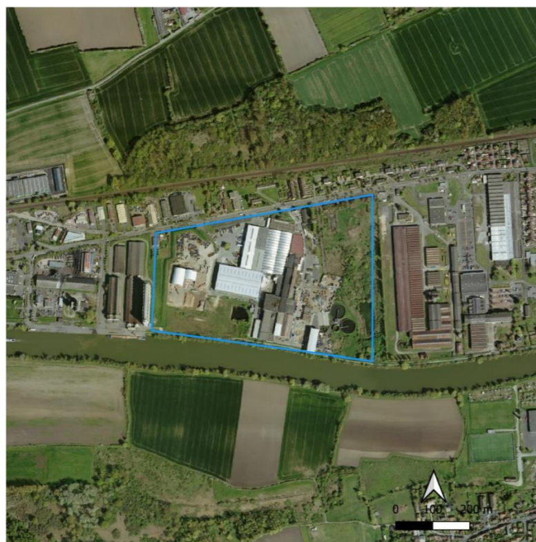
Illustration 32 : Vue aérienne de l'entreprise PSM (site n°7)
