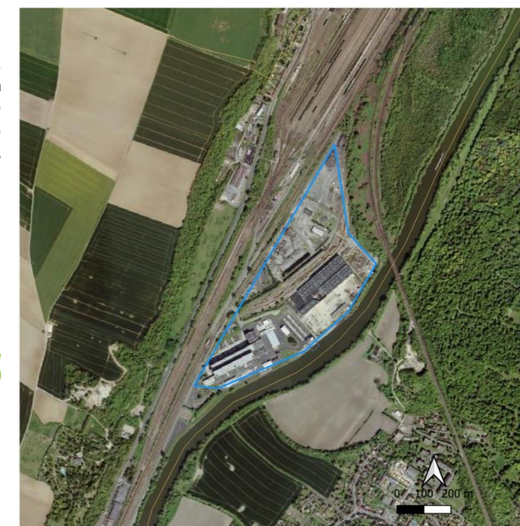
Illustration 30 : Vue aérienne de la zone industrielle du Renoir (site n°5)
