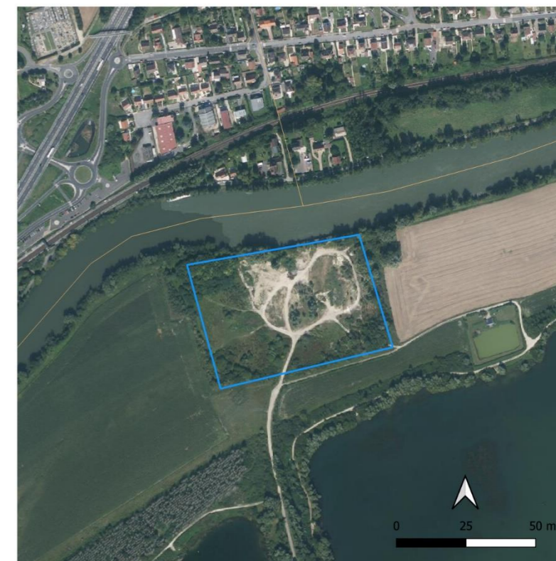
Illustration 33 : Vue aérienne de l'ancienne cimenterie à Verneuil en Halatte (site n°8)
